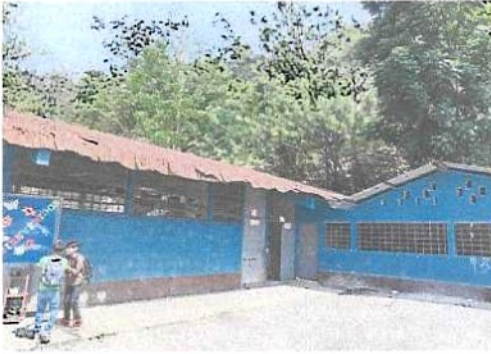
Foto1: Sustitución de láminas ya que se encuentran deterioradas por el paso del tiempo.
