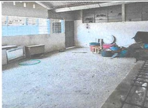
Foto 5: Reparación del piso de torta de concreto de la cocina.
