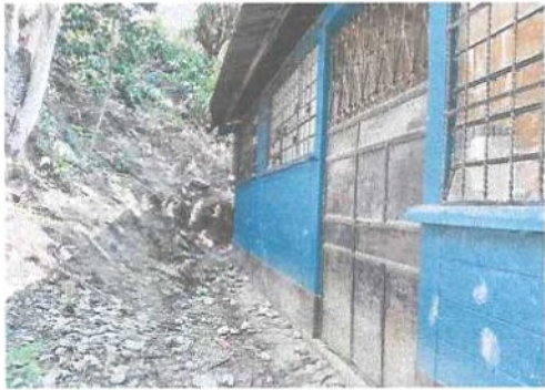
Foto 3: Sustitución de vidrios y mantenimiento de balcones de metal.
