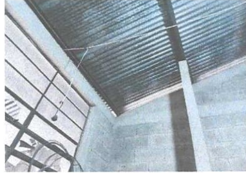
Foto 4: Reparación del sistema eléctrico en general con instalación de accesorios nuevos.
